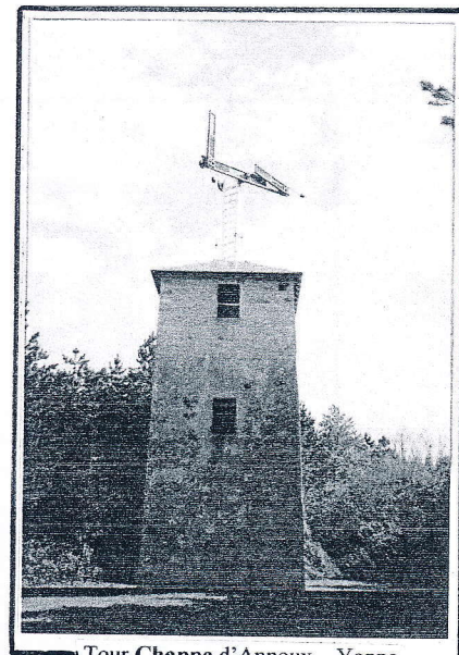
Tour Chappe d'Annoux – Yonne après restauration
